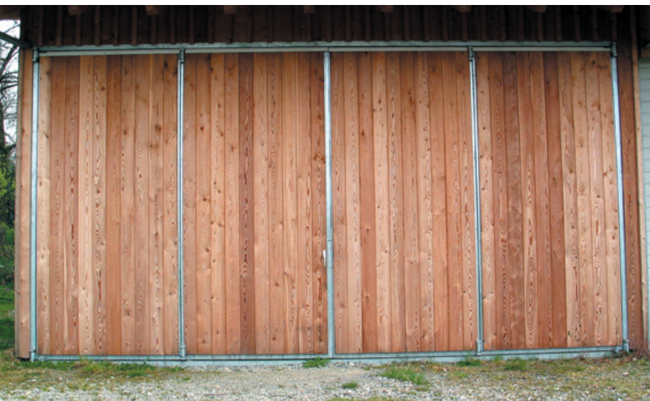
4-flügliges Falttor ohne Laufschiene mit Lärchenbretterverkleidung, Breite: 5,80 m x Höhe: 3,00 m
