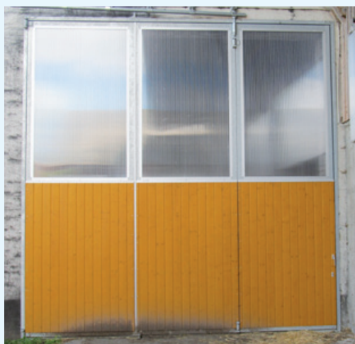
3-flügliges Falttor mit Laufschiene und Lichtband, Breite: 4,25 m x Höhe: 4,30 m
