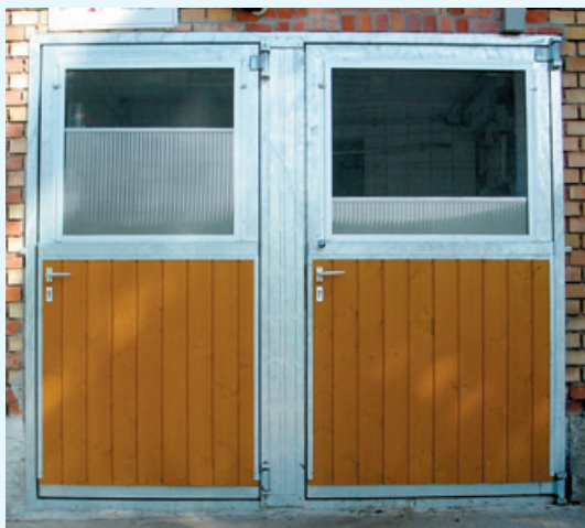
Milchkammertüre an herausnehmbarem Mittelpfosten angeschlagen
