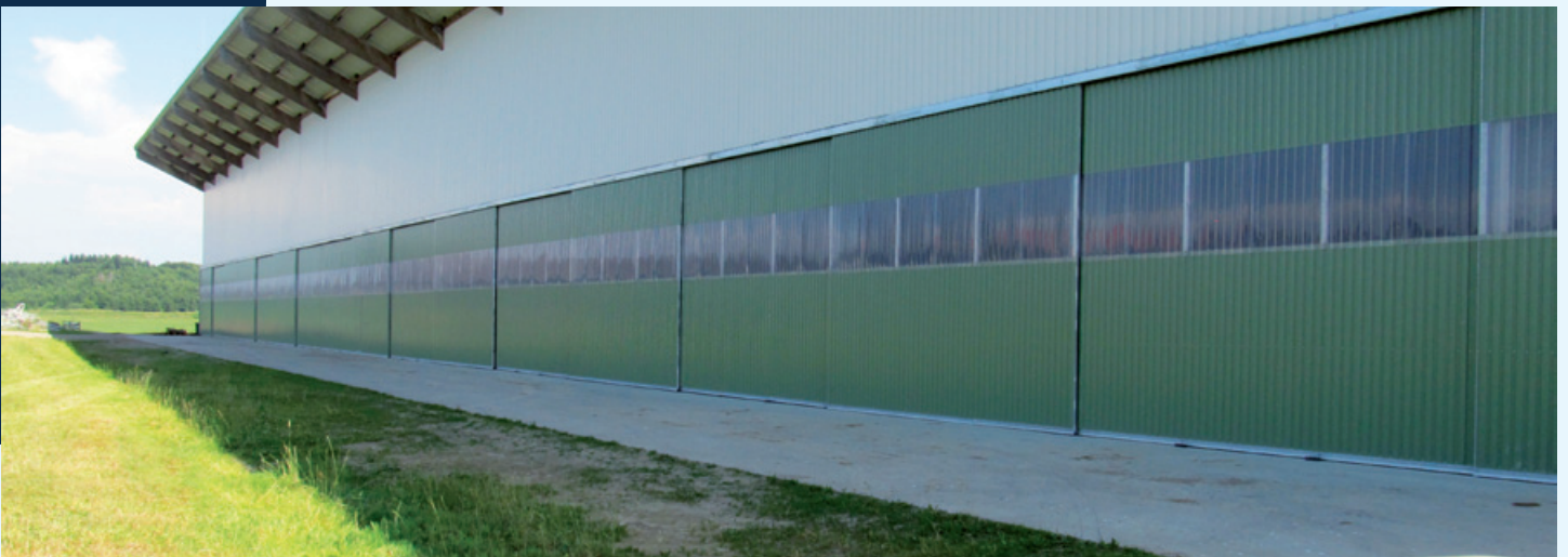
Hallenschubtore mit Trapezblechverschallung und Lichtband
