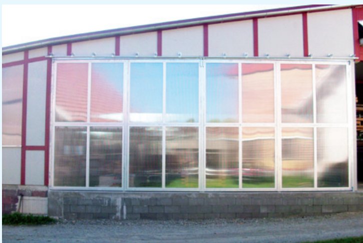
4-flügliges Falttor mit Laufschiene und 3-fach Stegplattenfüllung, Breite: 9,80 m x Höhe: 4,30 m
